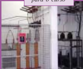
Obras e novas instalações para o curso
